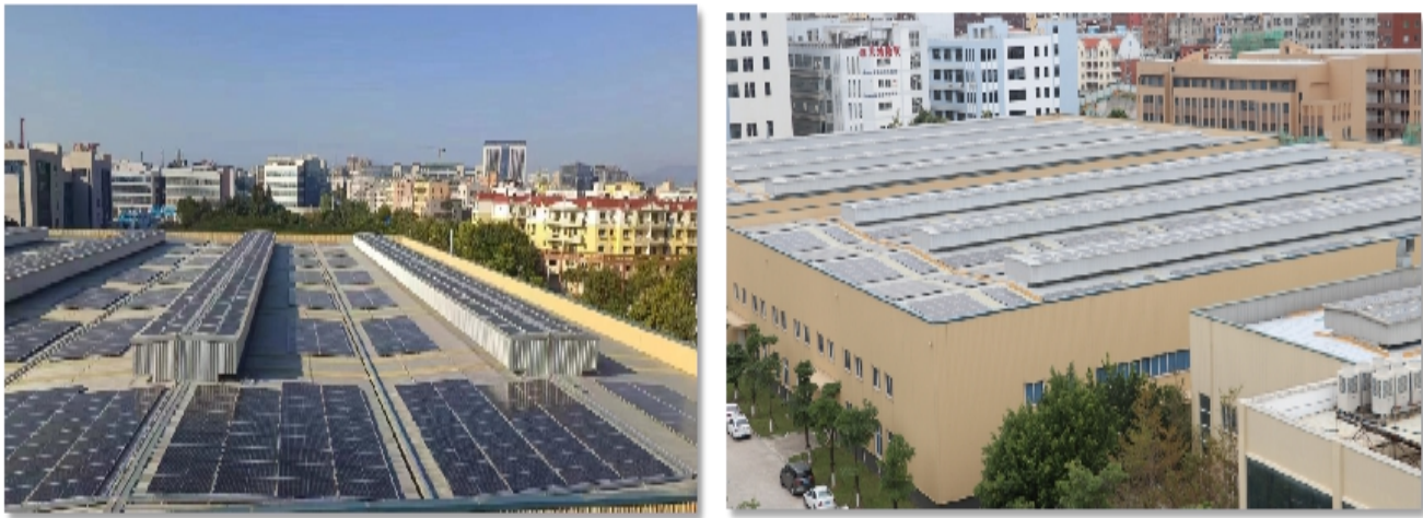
一期铺设完成的光伏屋顶
