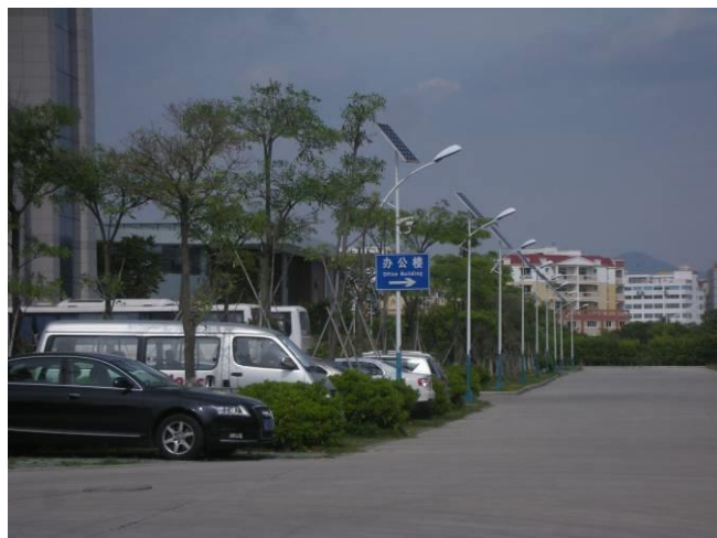
厂内太阳能路灯
