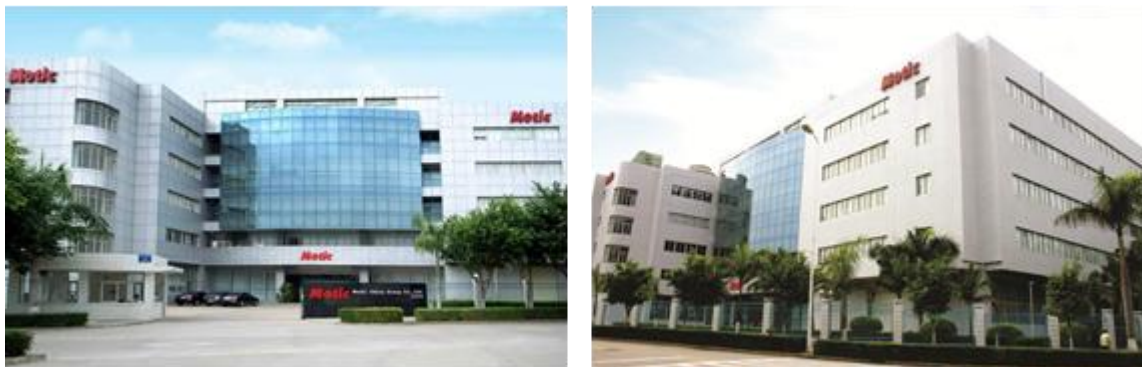
麦迪实业厦门总部办公室
